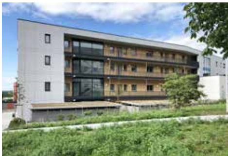
Nordseite Laubengänge Fotografie Michael Sattler
