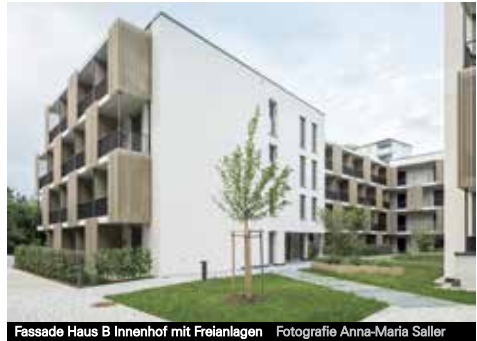
Fassade Haus B Innenhof mit Freianlagen Fotografie Anna-Maria Saller
