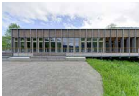
Neubau in Holzbauweise Fotografie Mark Wohlrab
