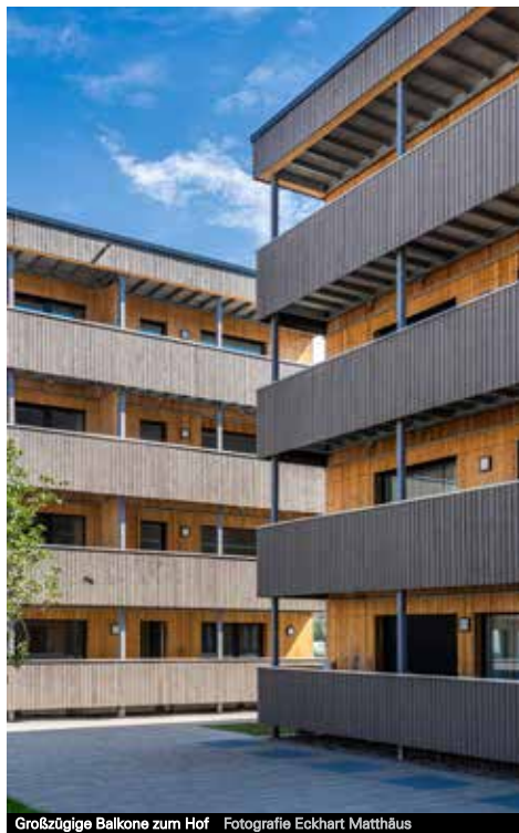
Großzügige Balkone zum Hof Fotografie Eckhart Matthäus
