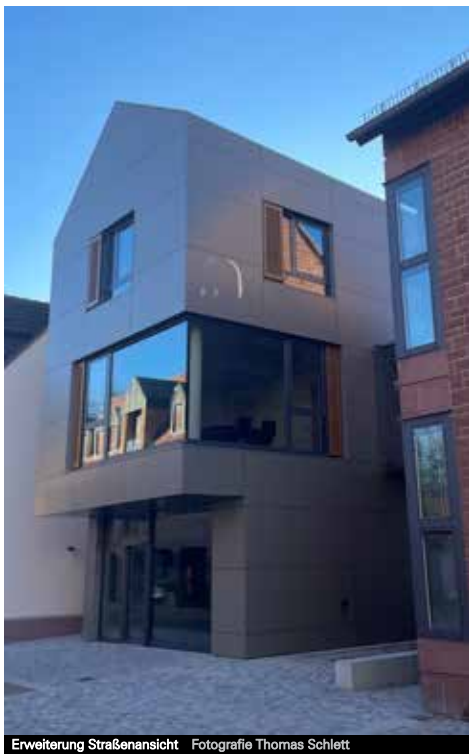
Erweiterung Straßenansicht Fotografie Thomas Schlett
