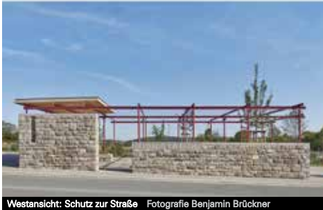
Westansicht: Schutz zur Straße Fotografie Benjamin Brückner
