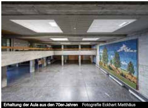
Erhaltung der Aula aus den 70er-Jahren Fotografie Eckhart Matthäus
