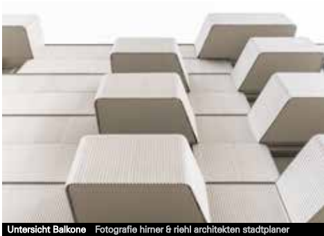
Untersicht Balkone Fotografie hirner & riehl architekten stadtplaner
