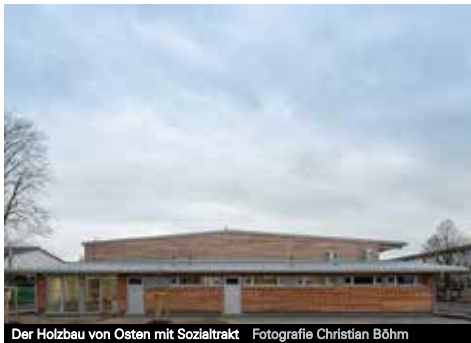
Der Holzbau von Osten mit Sozialtrakt Fotografie Christian Böhm
