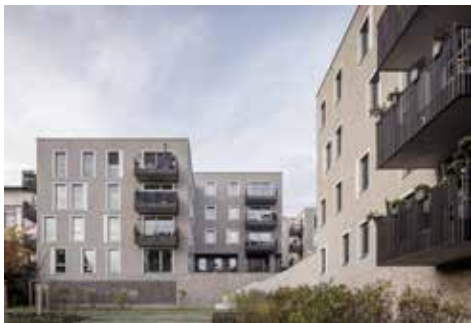
Südansicht Fotografie Rainer Taepper
