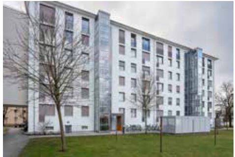
Nordseite mit Aufzügen Fotografie Daniele Aulenta
