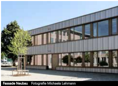
Fassade Neubau Fotografie Michaela Lehmann
