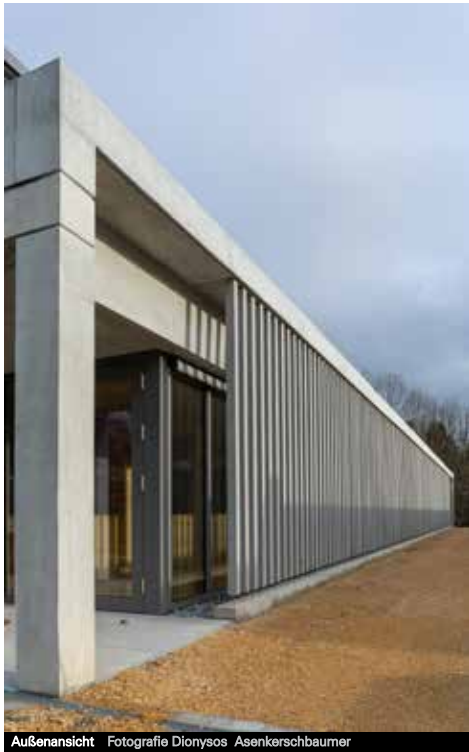
Außenansicht Fotografie Dionysos Asenkerschbaumer
