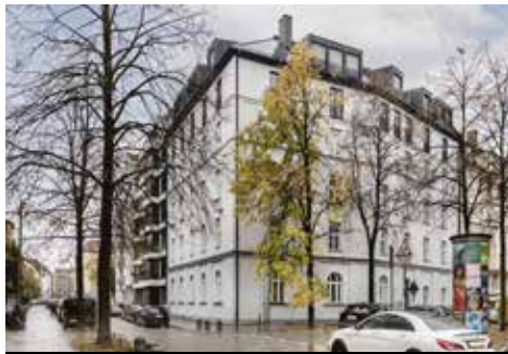
Dachausbau, Putzeneruerung, Innenaufzug Foto Adrienne-Sophie Hoffer
