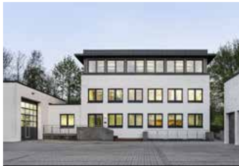
Ansicht von Norden Fotografie Peter Litvai
