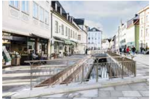
Geländer: Knopp Wassmer Architekten Fotografie Adrienne-Sophie Hoffer
