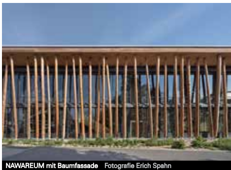
NAWAREUM mit Baumfassade Fotografie Erich Spahn
