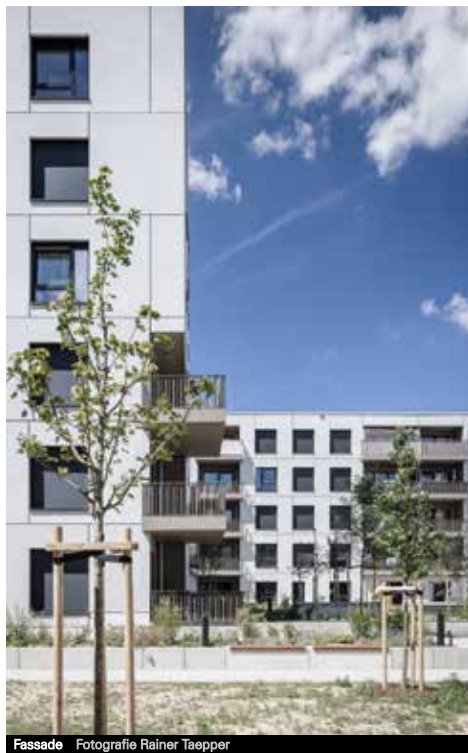
Fassade Fotografie Rainer Taepper
