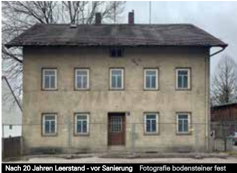
Nach 20 Jahren Leerstand - vor Sanierung Fotografie bodensteiner fest
