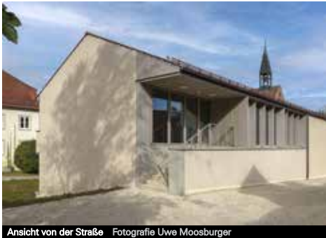
Ansicht von der Straße Fotografie Uwe Moosburger
