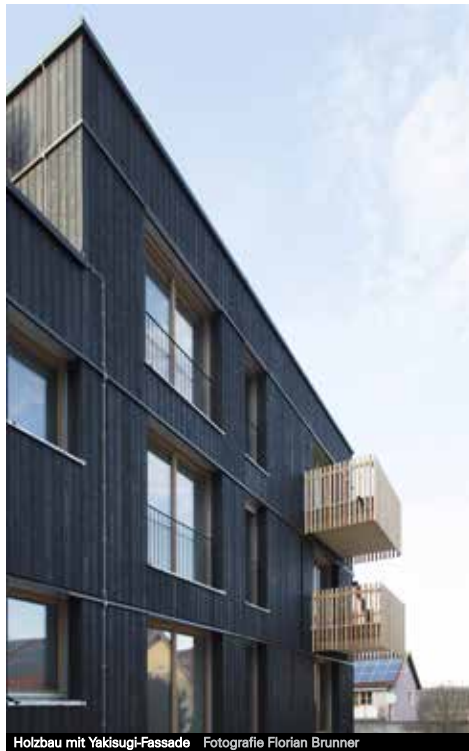
Holzbau mit Yakisugi-Fassade Fotografie Florian Brunner
