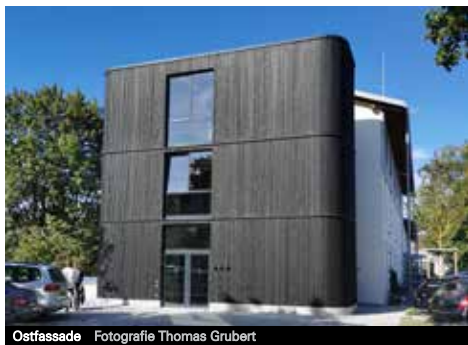
Ostfassade Fotografie Thomas Grubert
