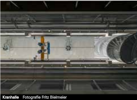
Kranhalle Fotografie Fritz Bielmeyer
