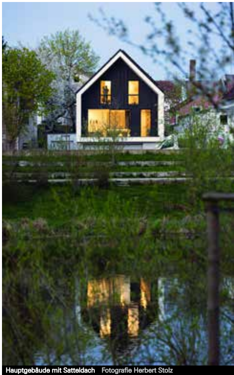
Hauptgebäude mit Satteldach Fotografie Herbert Stolz
