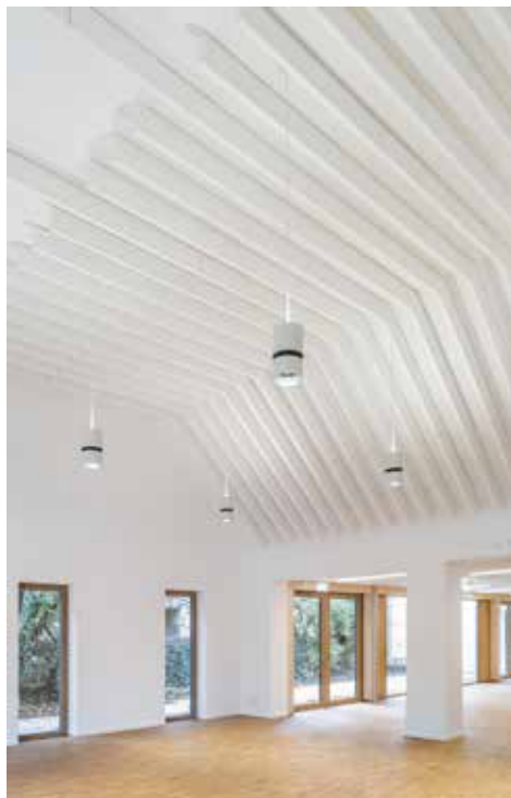
Saalumbau mit Blick ins neue Foyer Fotografie Oliver Heint
