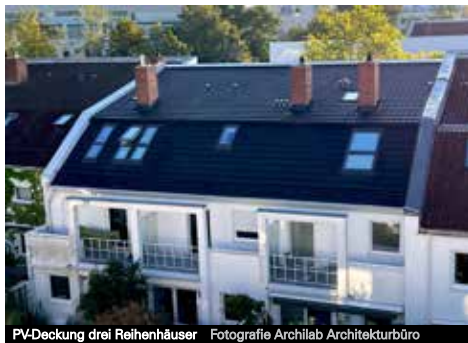
PV-Deckung drei Reihenhäuser Fotografie Archilab Architekturbüro
