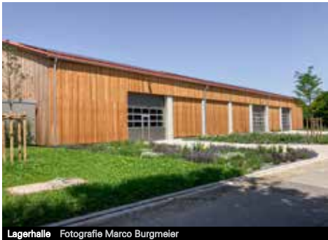
Lagerhalle Fotografie Marco Burgmeier
