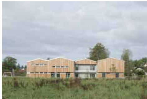
Ansicht von Osten Fotografie Florian Holzherr
