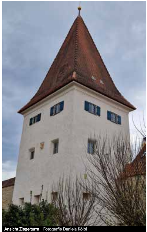
Ansicht Ziegturm Fotografie Daniela Kölbl
