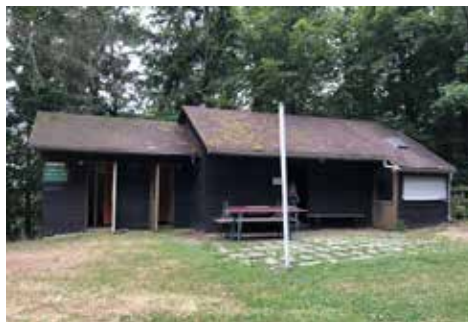
Bestandsgebäude Fotografie ppp planungsgruppe
