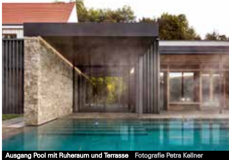
Ausgang Pool mit Ruheraum und Terrasse Fotografie Petra Kellner
