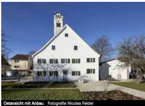
Ostansicht mit Anbau Fotografie Nicolas Felder
