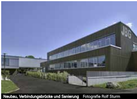
Neubau, Verbindungsbrücke und Sanierung Fotografie Rolf Sturm
