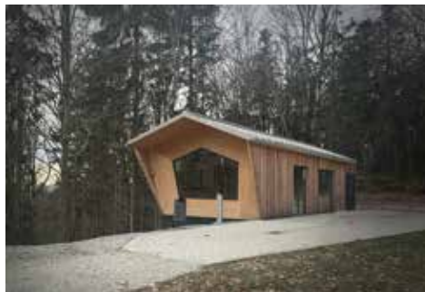
Außenansicht Fotografie ppp planungsgruppe
