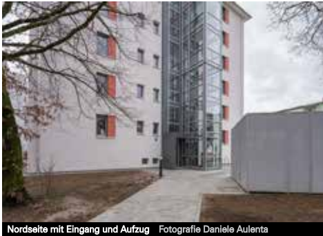
Nordseite mit Eingang und Aufzug Fotografie Daniele Aulenta
