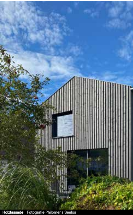
Holzfassade Fotografie Philomena Seelos
