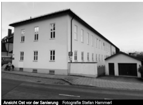
Ansicht Ost vor der Sanierung Fotografie Stefan Hammerl
