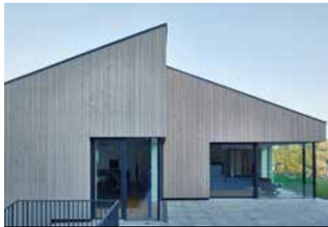
Ansicht von Süden Fotografie Alexander Bernhard
