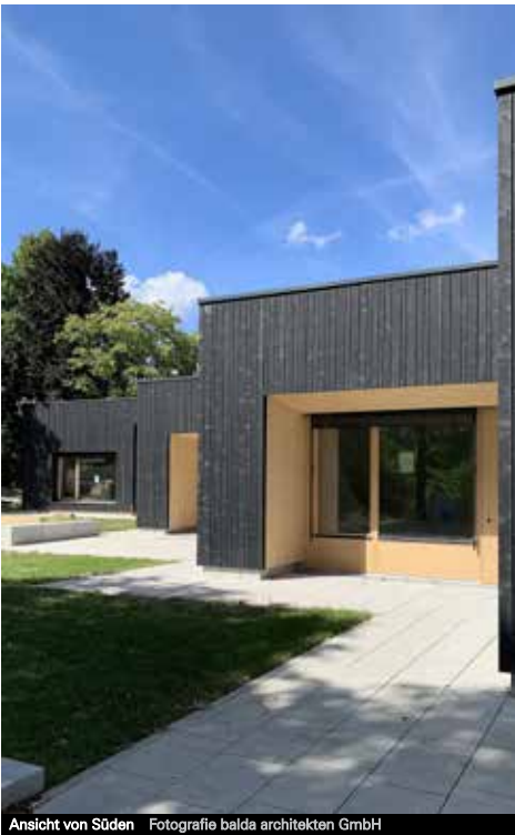
Ansicht von Süden Fotografie balda architekten GmbH
