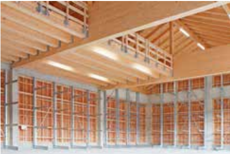
Holzlagerhalle innen Fotografie Jorinde Schlichtig
