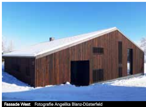
Fassade West Fotografie Angelika Blanz-Düsterfeld
