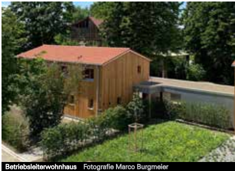
Betriebsleiterwohnhaus Fotografie Marco Burgmeier
